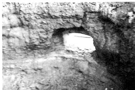
图 3 第 250 炉次时渣线、熔池与炉门框侵蚀情况
